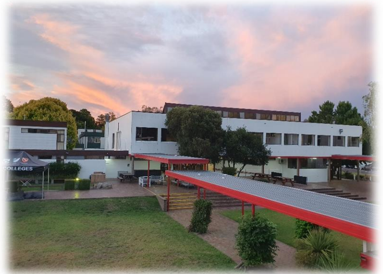
Blick auf Courtyard (courto) und die Dining Hall (dino) des Austin Page College
