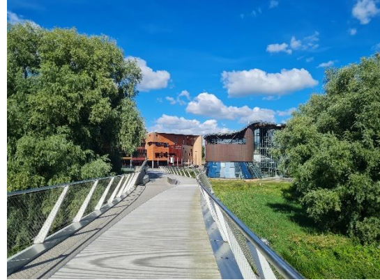
Blick auf den Nordcampus von der Living Bridge
