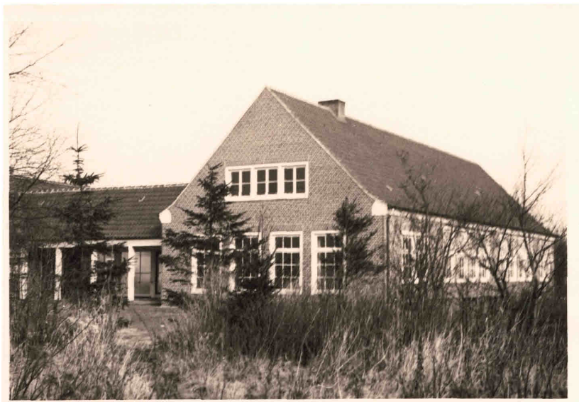
Das Schulgebäude in Arle – hinter den drei Fenstern im Dachgeschoss der Werkraum, in dem wir zwei Studenten für 6 Wochen kostenfrei untergebracht wurden.
