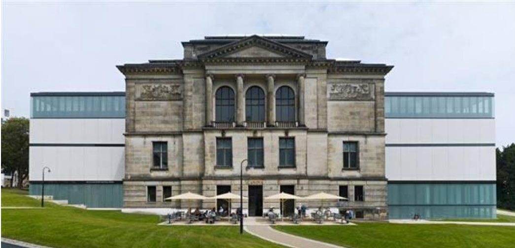
Abbildung 9: Kunsthalle Bremen mit Alt- und Neubau, Erdsondenfeld unter dem Neubau und unter dem Rasen im Vordergrund. Quelle: Kunsthalle Bremen
