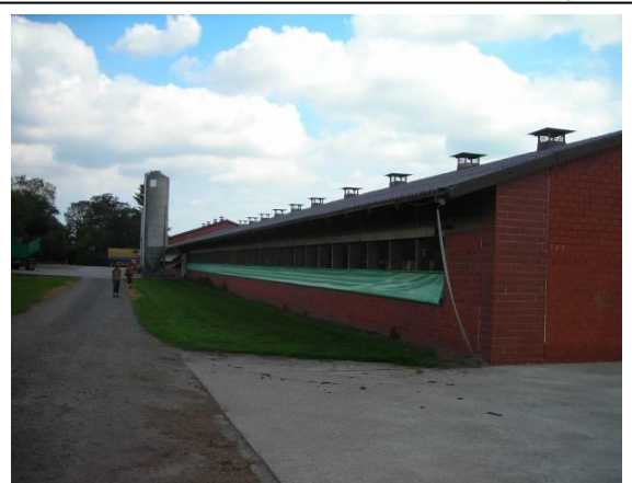
Abbildung 12: Westwand eines Putenstalls auf dem Hof Siemering mit „offenem Vorhang“, Foto: Borderstep
