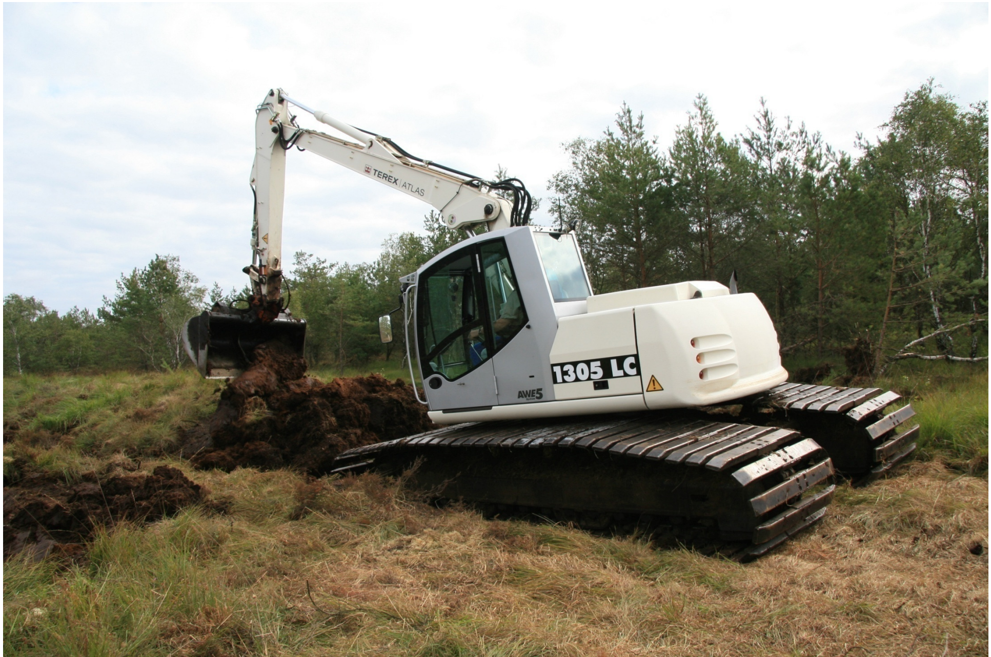
Torfbagger beim Bau eines Ringwalls, Krähenmoor bei Nienburg 2009
