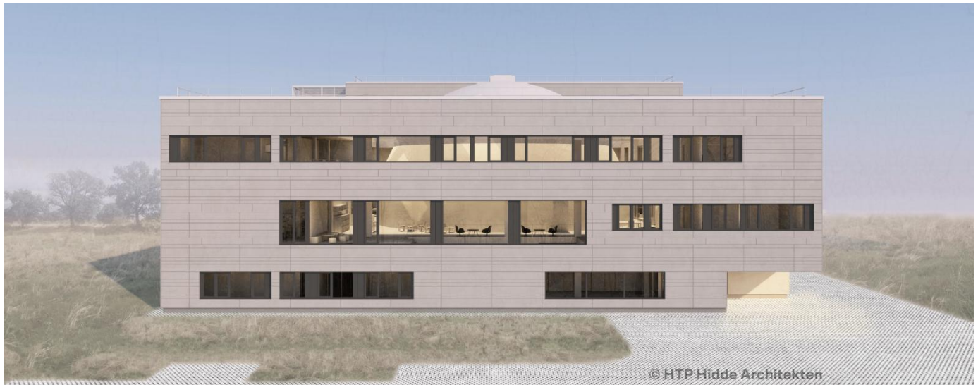
Bild: HTP Hidde Architekten
