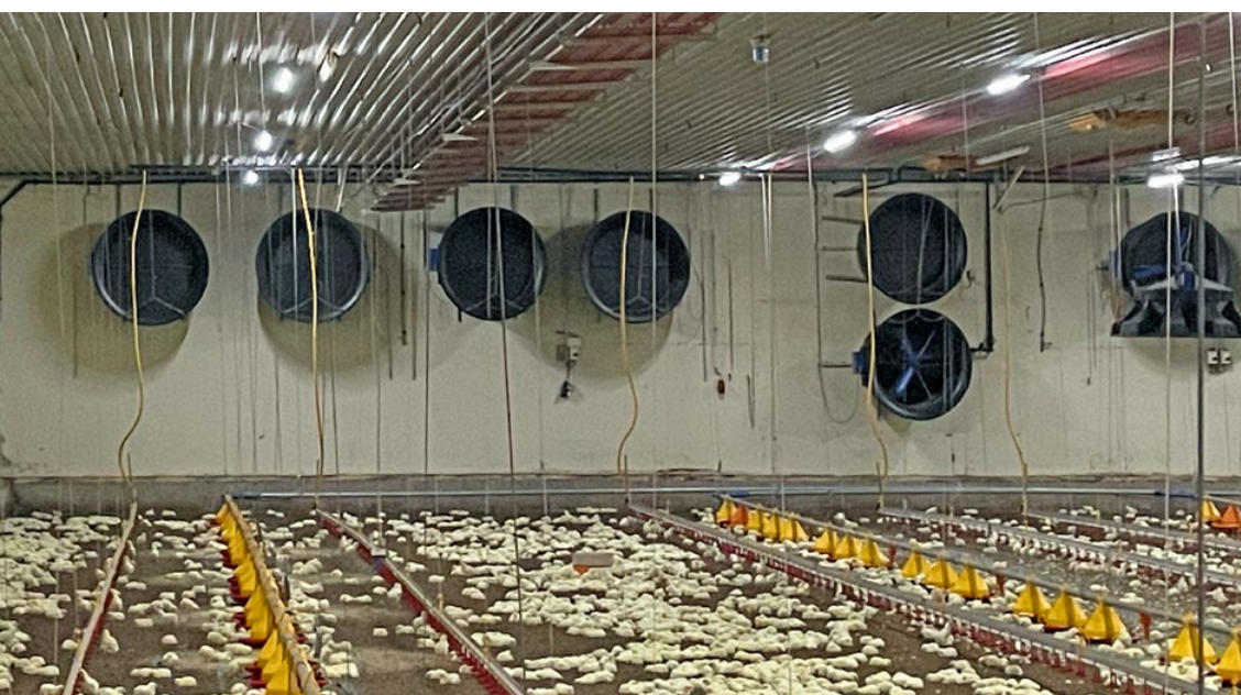
Das neue Musterhaus für Masthühner erzeugt ein tierfreundlicheres Stallklima mit geringen Temperaturschwankungen. Die Frischluft wird vor Eintritt in den Stall effektiv temperiert, Zu- und Abluft sowie Emissionen werden besser kontrolliert.
