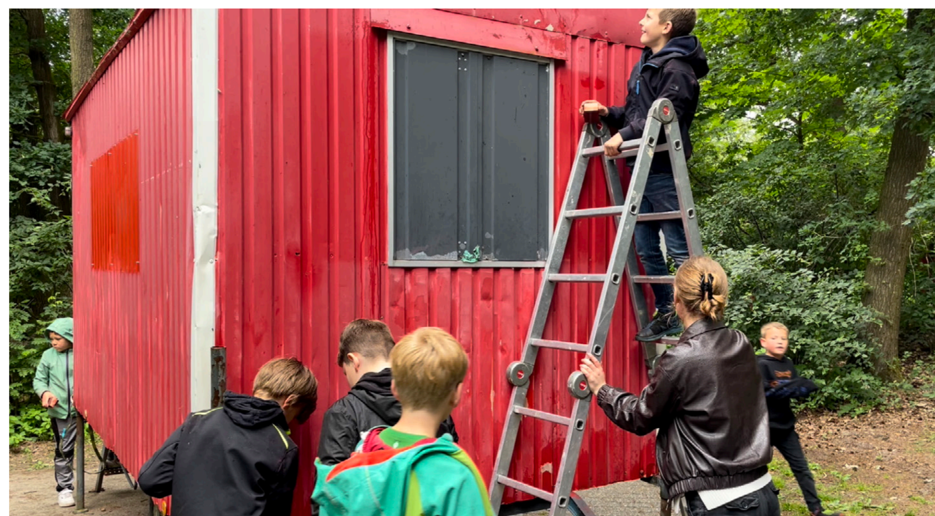
Abb. 2. Umbau eines Bauwagens: Schleifen der Außenfassade vor dem Anstrich.
