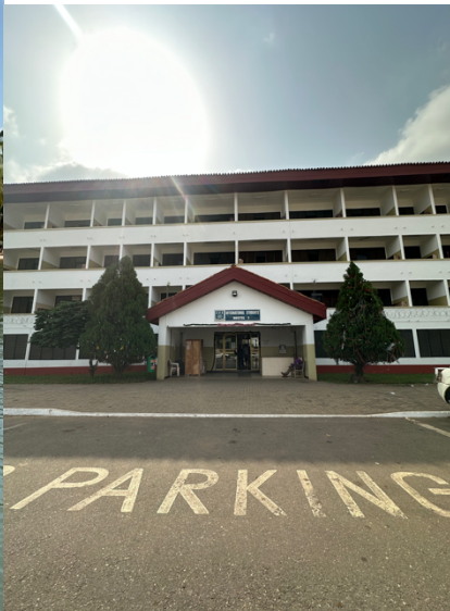
Der Eingang vom ISH 1
