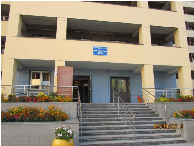
Abb.1 Eingang ins Studentenwohnheim, Baujahr 2011
