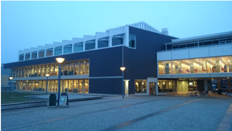
3 Die Bibliothek ist ebenso wie die üblichen Gebäude hochmodern und außergewöhnlich ausgestattet
