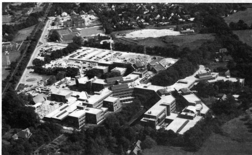
Einzugsbereit: Die naturwissenschaftlichen Gebäude auf dem Standort Wechloy, die mit einem Kostenaufwand von 175 Millionen Mark errichtet wurden.
