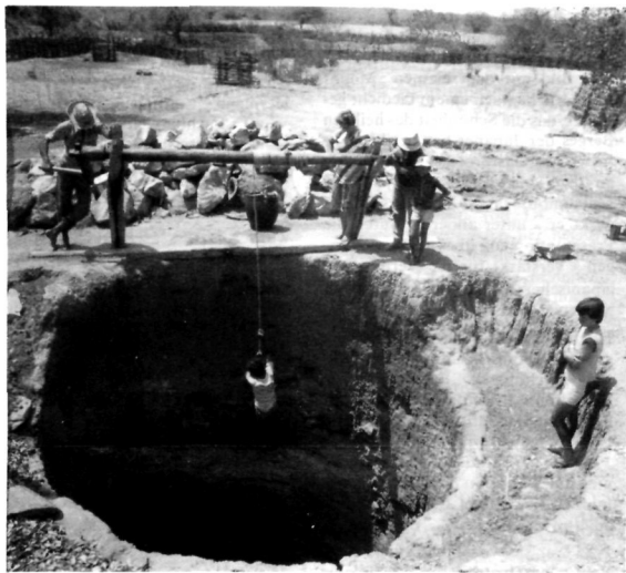
Der Bau solcher Brunnen soll durch die Oldenburger Hilfsaktion im Bundesstaat Ceara finanziert werden.
