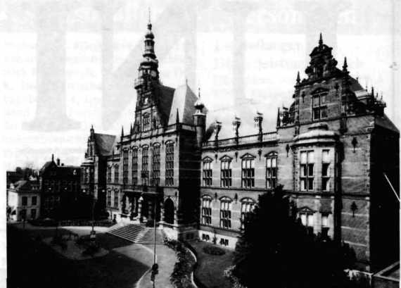
Das Hauptgebäude der Rijksuniversiteit te Groningen
